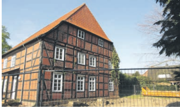
Damit an allen Seiten des Hauses gearbeitet werden kann, musste ein Teil der Parkplätze mit einem Bauzaun abgesperrt werden. Für die sich hieraus ergebenden Einschränkungen während der Bauarbeiten bitten wir um Verständnis.
