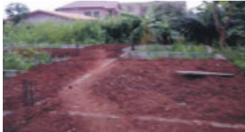
Das Baugrundstück mit zum Teil verfülltem Fundament.
