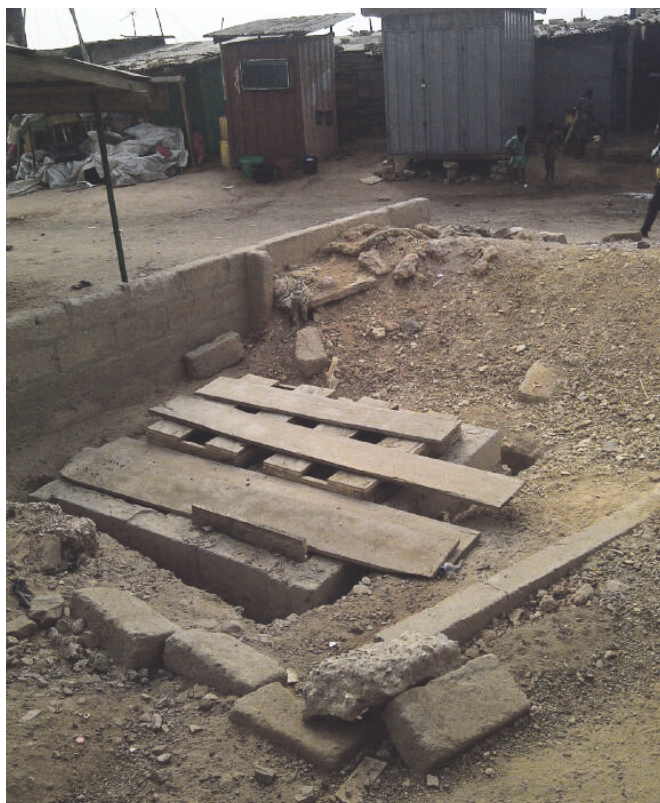
Hier werden mit Hilfe der Spenden Toiletten entstehen!
